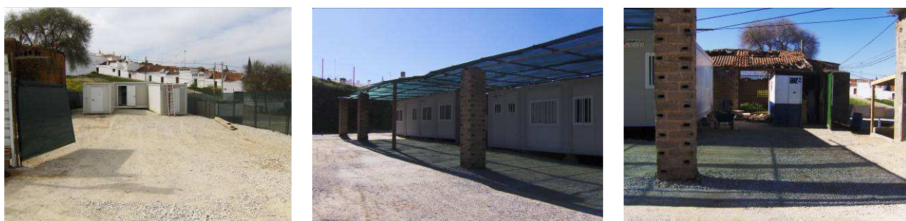
FIG. 2 – Contentores de Escritórios, dormitórios e Ferramentaria existentes no Estaleiro
