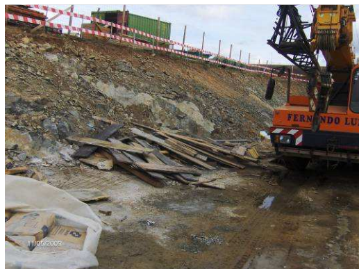
FIG. 9 – Vedações de arame e madeira existentes em toda a envolvente da Estação Elevatória
