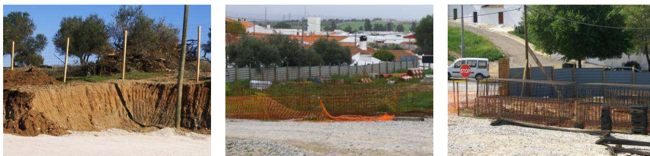
FIG. 4 – Vedação existente em toda a envolvente do Estaleiro
