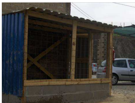
FIG. 5 – Construção para armazenagem de Produtos Perigosos
