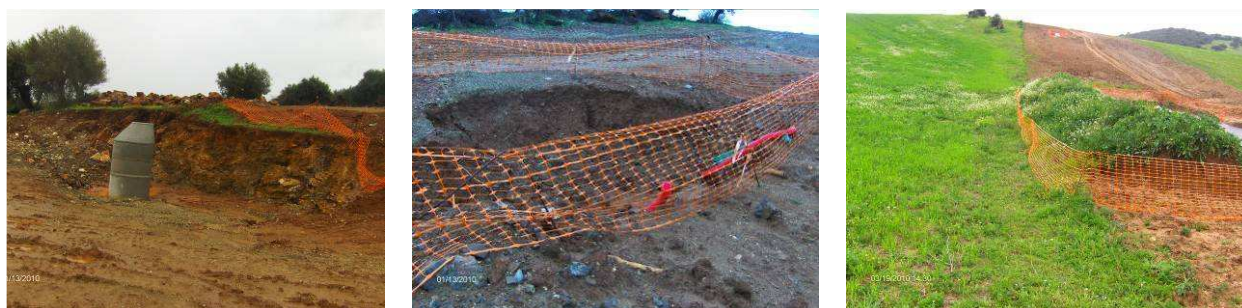
FIG. 10 – Redes Laranja existentes ao longo do adutor
