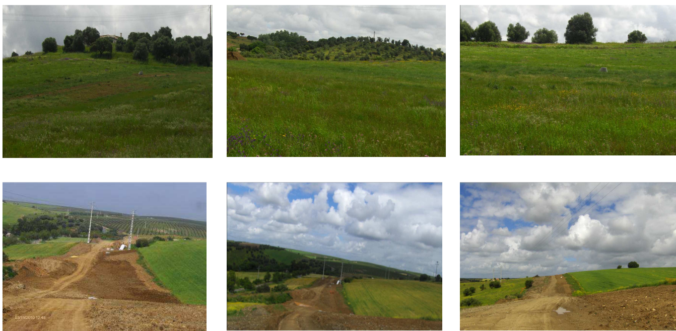
FIG. 11 – Situação actual dos terrenos intervencionados para construção do Adutor
